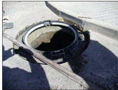
Sujeción con hormigón. Dejar escalón de 2 a 3 cm para el asfalto en frío. Enlucir interior del marco dejando hueco para el pestillo de la tapa.
