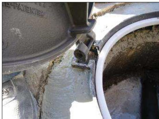
Enlucir interiormente el marco con mezcla de cemento rápido y arena, dejando el hueco suficiente para el pestillo de la tapa y garras del marco.
