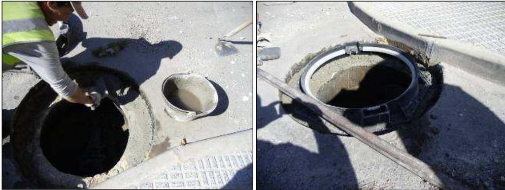
Sujeción con hormigón. Dejar escalón de 2 a 3 cm para el asfalto en frío. Enlucir interior del marco dejando hueco para el pestillo de la tapa.
